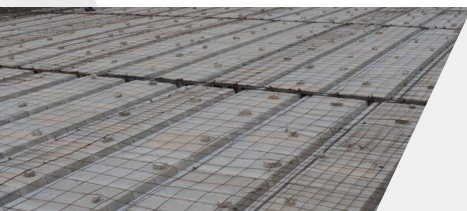
Firme de compresión con malla electro-soldada.
